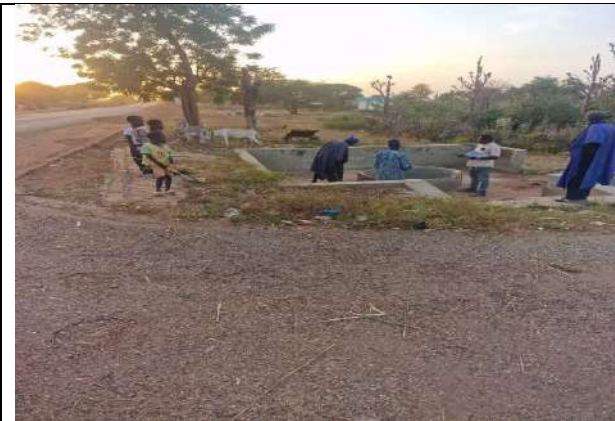
Vue à la bordure de la route Puit à grand Diamètre de Madina Camara
